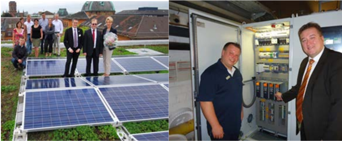
Abbildung 21 und 22: Links: Auch Photovoltaikanlagen zur Eigenstromversorgung wie hier auf dem Helmholtz-Gymnasium werden aus Mitteln des Klimaschutzfonds realisiert (Quelle: Stadt Karlsruhe, Müller-Gmelin). Rechts: Technik mit hohem Einsparpotenzial: Nachträgliche Installation von Frequenzumformern für die Umwälzpumpen im Weiherhofbad (Quelle: Stadt Karlsruhe, Roland Fränkle).
