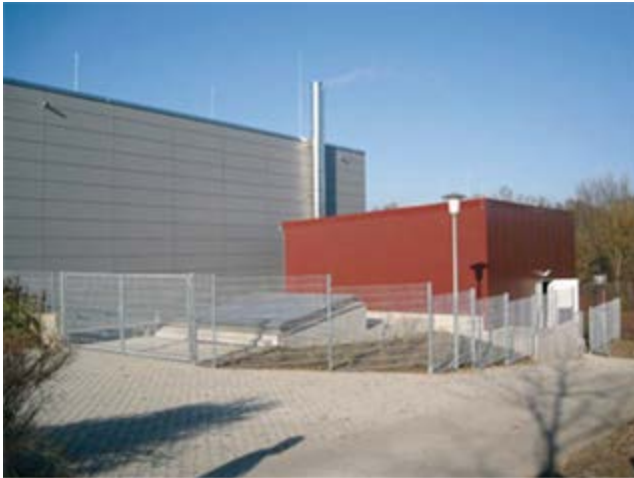
Abbildung 20: Heizzentrale in Riedlingen (Quelle: Energieatlas Baden-Württemberg).
