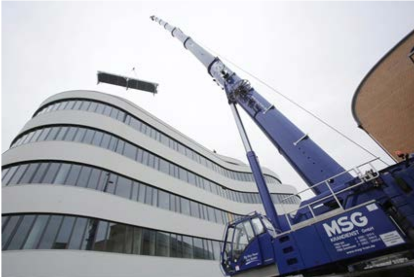
Bild 1: Installation der Rückkühlanlage auf dem Dach des SYNUS-Gebäude (Quelle: Stadtwerke Karlsruhe GmbH)
