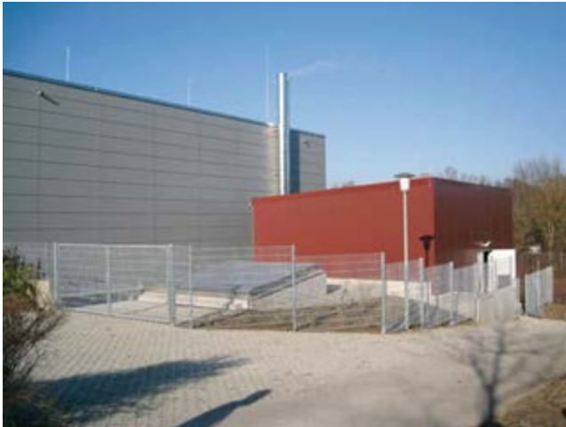
Bild 14: Heizzentrale in Riedlingen (Quelle: Energieatlas Baden-Württemberg)
