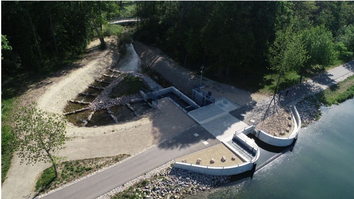
Abbildung 9: Einlassbauwerk mit Fischpassgerinne am RHR Kulturwehr Breisach – Foto: RP Freiburg
