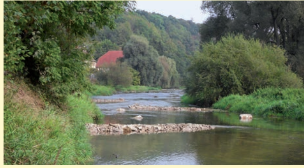
Niedrigwasserbuhnen und Störsteine tragen zur Erhöhung der Strömungsdiversität bei.
