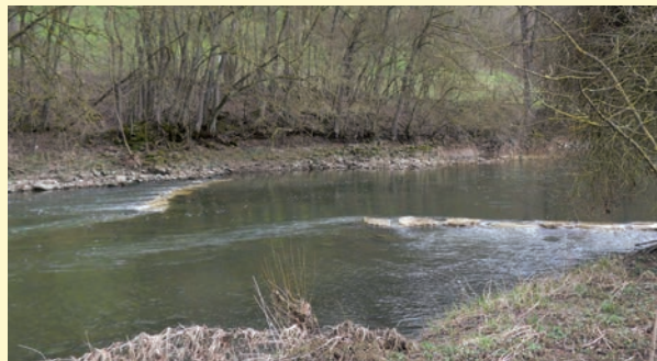
Einbau von Strömungstrichtern zur Erzeugung von Strömungsvarianzen bei Oberregenbach.
