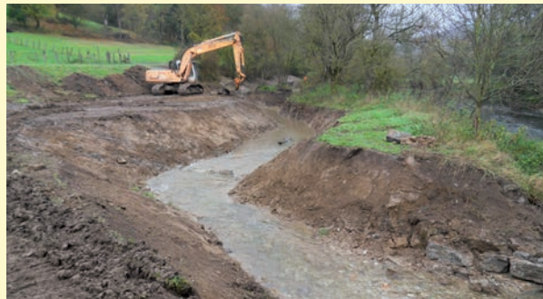
Wiederanbindung eines verlandeten Altarms an die Jagst bei Unterregenbach.
