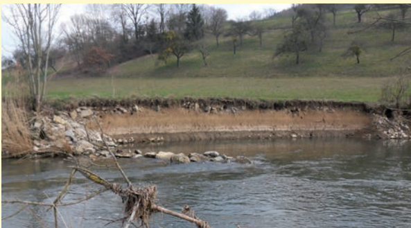
Durch die Entfernung von Uferbefestigungen kann eigendynamische Gewässerentwicklung ermöglicht werden.
