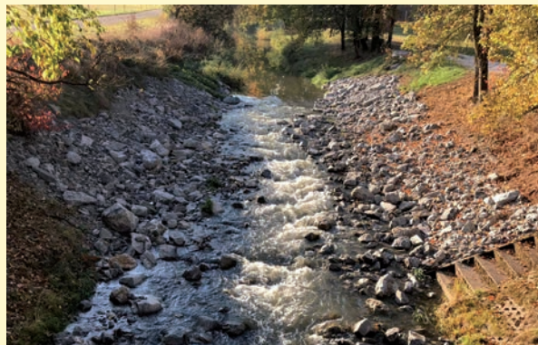
Nach dem Umbau in eine raue Rampe ist die Jagst wieder für Fische passierbar.
