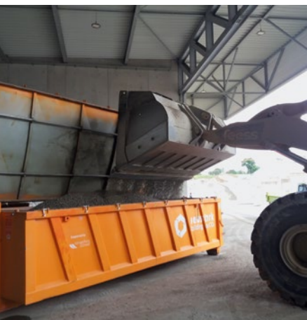
Container zur Karbonatisierung wird beschickt
