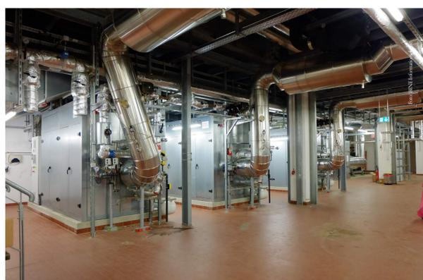
Ein BHKW erzeugt Wärme und Strom gleichzeitig und ist eine besonders effiziente Lösung
