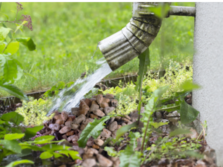
Regenwasserversickerung statt Einleitung in die Kanalisation
