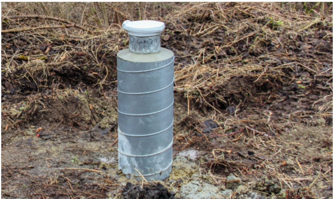
Peilrohr einer Grundwassermessstelle in Baden-Württemberg
