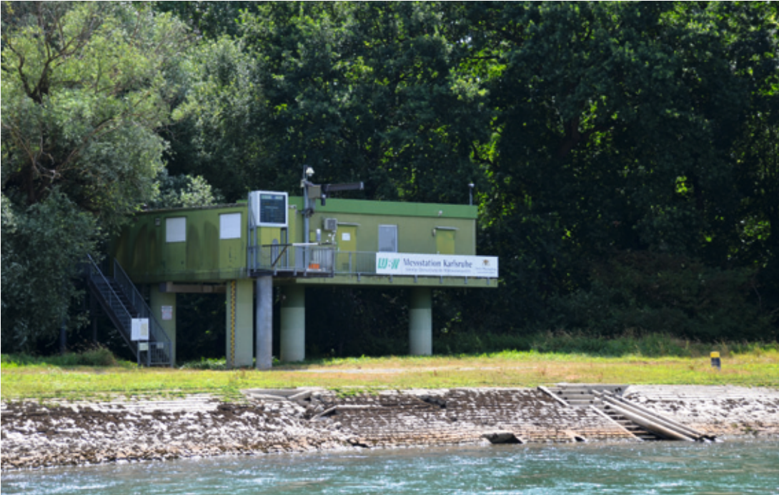
Wassergütemessstation Karlsruhe beim Rheinhafen
