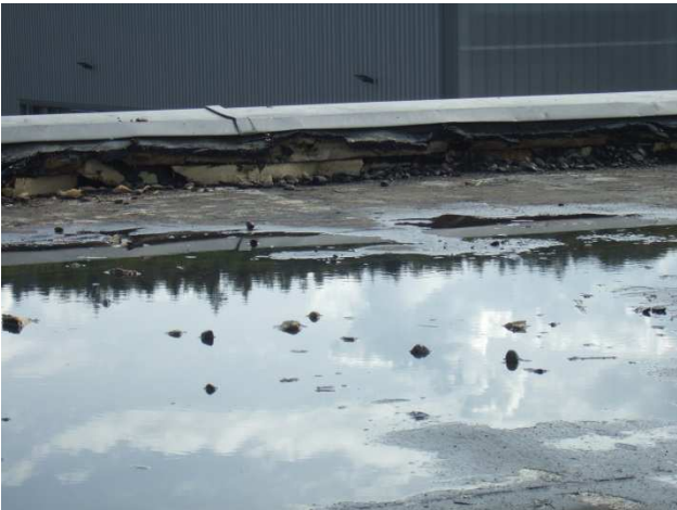
Abbildung 6.6: Abtragen der Abdeckung und Dämmung des Flachdaches
