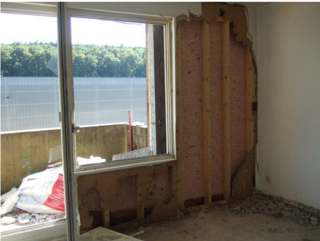
Abbildung 6.7: Ausbau der Innendämmung und Innenverkleidung
