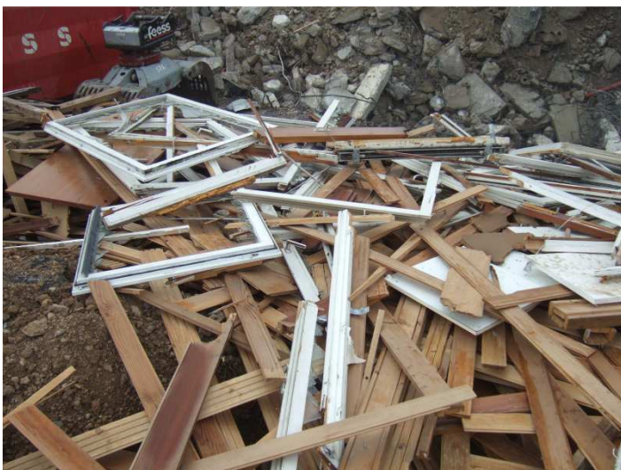
Abbildung 6.13: Getrennte Bereitstellung von Holz
