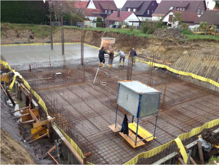
Abbildung 3.1: Betonage der Bodenplatte
