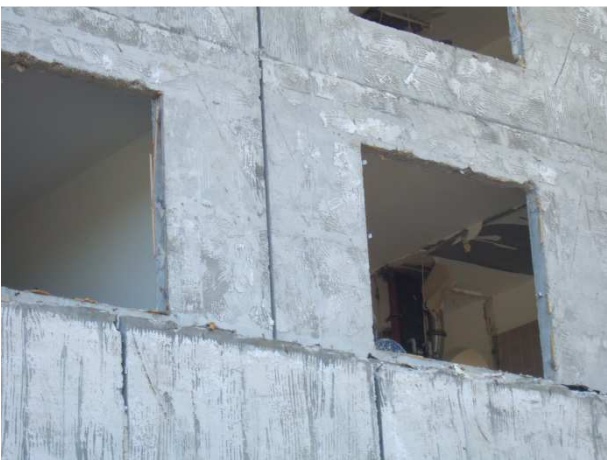
Abbildung 6.8: Ausbau der Fenster und Türen inkl. Zargen
