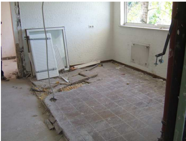
Abbildung 6.5: Ausbau der Innenwände (Gipsdielen)
