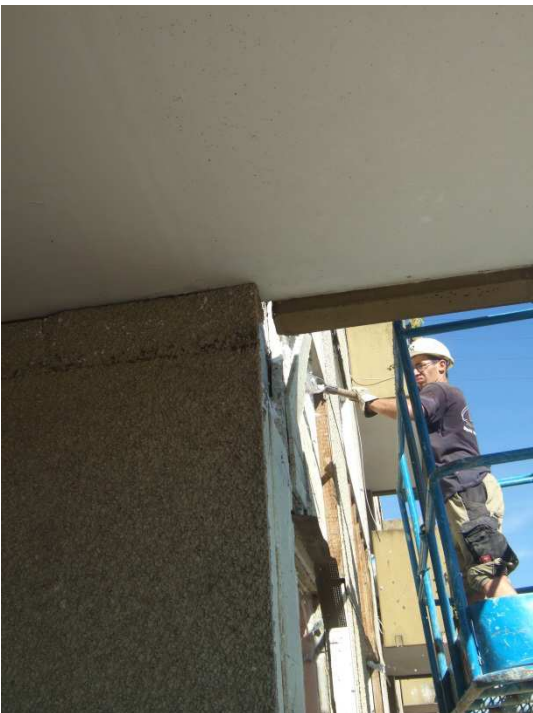
Abbildung 6.10: Entfernen des Wärmedämmverbundsystems um die Balkone herum auch händisch
