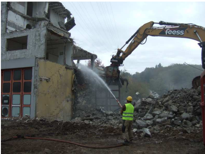
Abbildung 6.11: Rückbau und Unterdrückung von Staubemissionen
