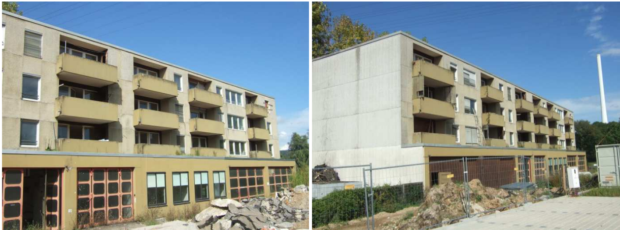
Abbildung 6.4: Zum Rückbau vorgesehene Gebäude in Denkendorf
