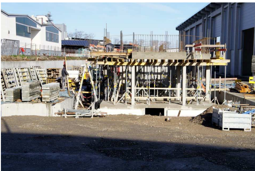
Abbildung 3.11: Bauzustand zum Zeitpunkt der Besichtigung
