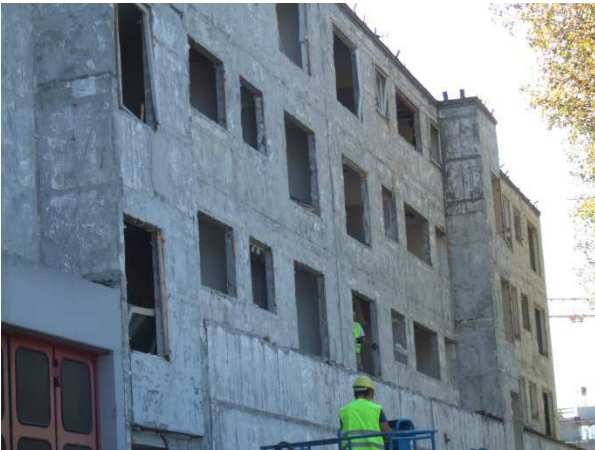
Abbildung 6.9: Entfernen des Wärmedämmverbundsystems
