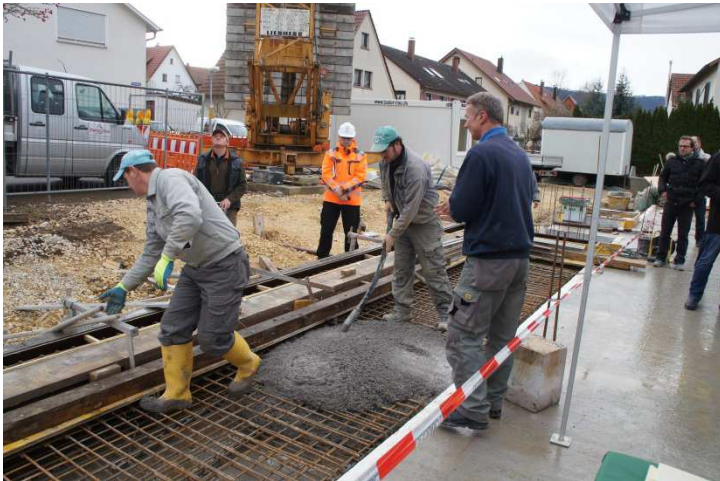
Abbildung 3.3: Einbau von R-Beton
