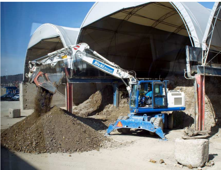
Abbildung 9.4: Bodenbearbeitung / Abtrennung einer Körnung durch eine Separatorschaufel
