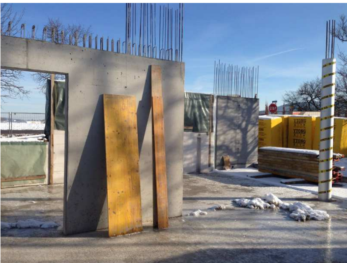
Abbildung 3.2: Wände und Stützen im Erdgeschoss
