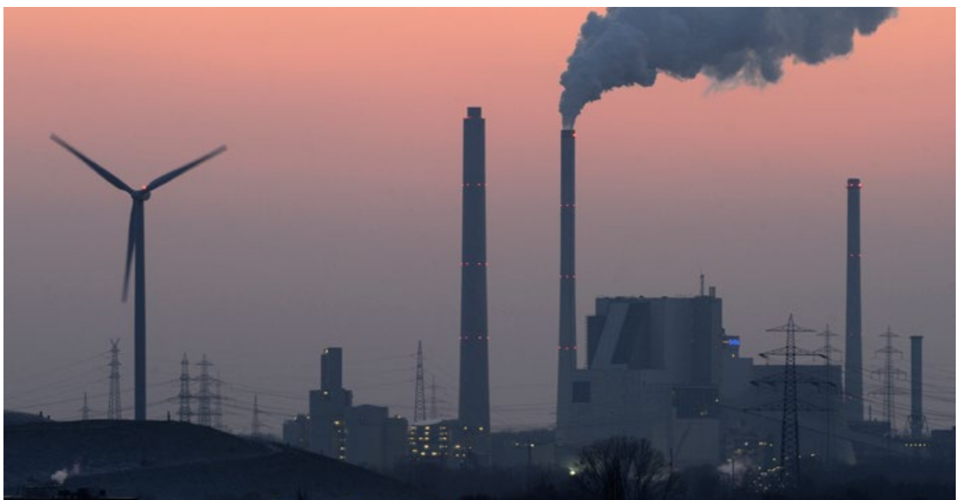
WINDENERGIEANLAGE UND STEINKOHLEKRAFTWERK NEBENEINANDER (KARLSRUHE)
