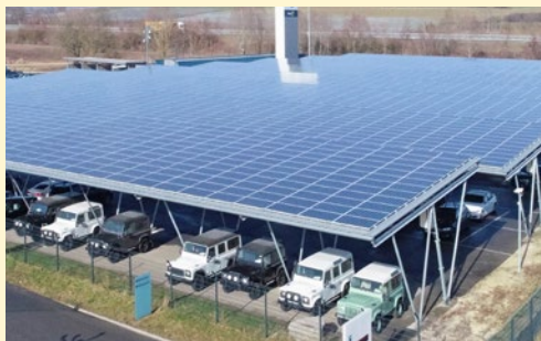
Die Photovoltaik-Dächer der Firma Auer in Stockach dienen auch zum Schutz der Fahrzeuge vor Hitze und Unwetter.
