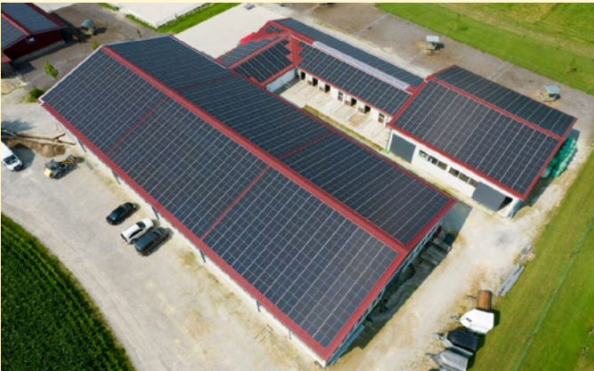
Werden Dächer bereits bei der Planung für die Solarnutzung optimiert, lassen sich große Flächen nutzen: Reiterhof in Gensenweiler mit nahezu vollständiger solarer Dachnutzung.
