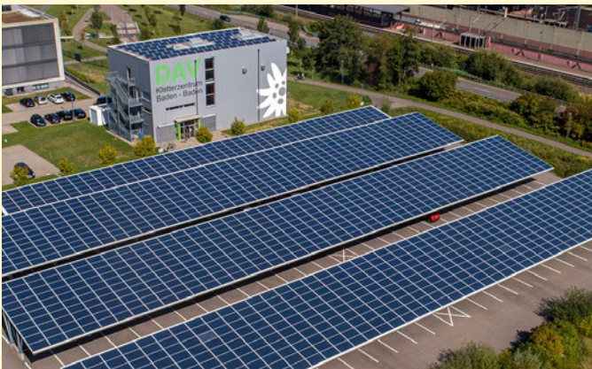
Park&Ride-Parkplatz der Stadtwerke Baden-Baden mit 371,3 kWp Photovoltaik
