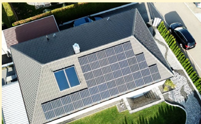
Photovoltaik-Module und zwei thermische Solarkollektoren auf einem Haus in Mengen. Solarkollektoren werden auf die Mindestfläche der Photovoltaik-Module angerechnet.
