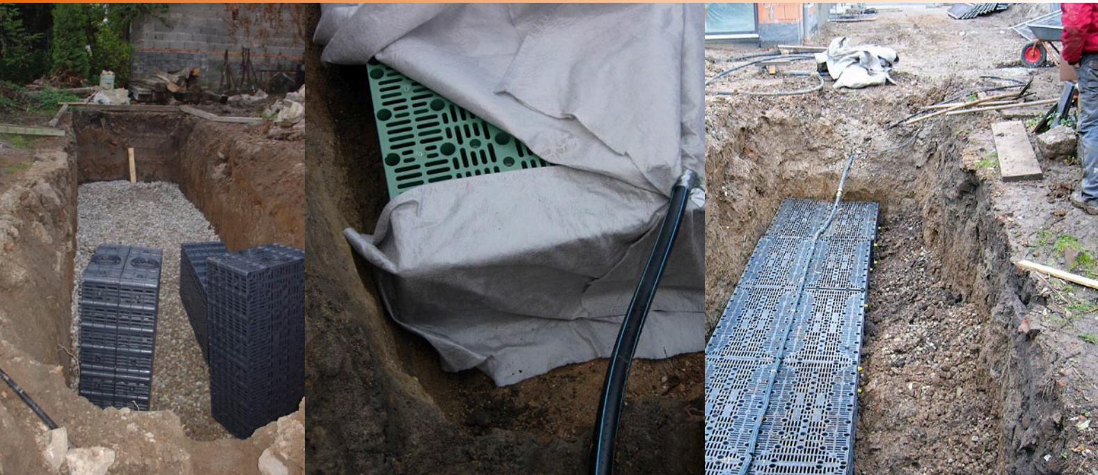
links und rechts: Einbau von Sickerblocks; Mitte: Sickerblock mit Schutzflies (Bildquelle: MHK Wärme- und Kältetechnik GmbH, Waghäusel)
