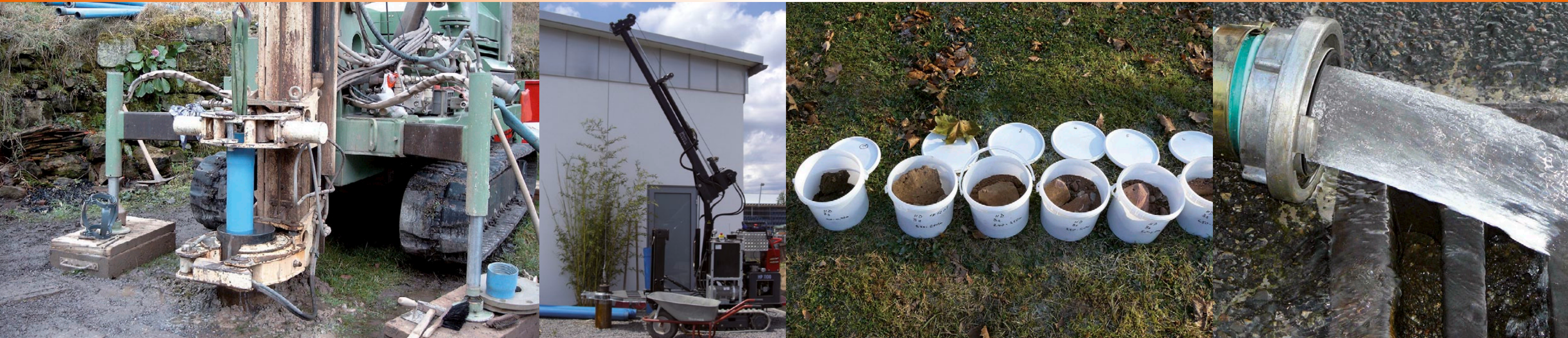
Bohrungen für Grundwasserwärmepumpen, links: im Festgestein (Bildquelle: Hydrogeologisches Büro Dr. Köhler, Eppingen), rechts: im Lockergestein (Bildquelle: Firma Krämer Bewässerung GmbH, Dettenheim-Rußheim).
